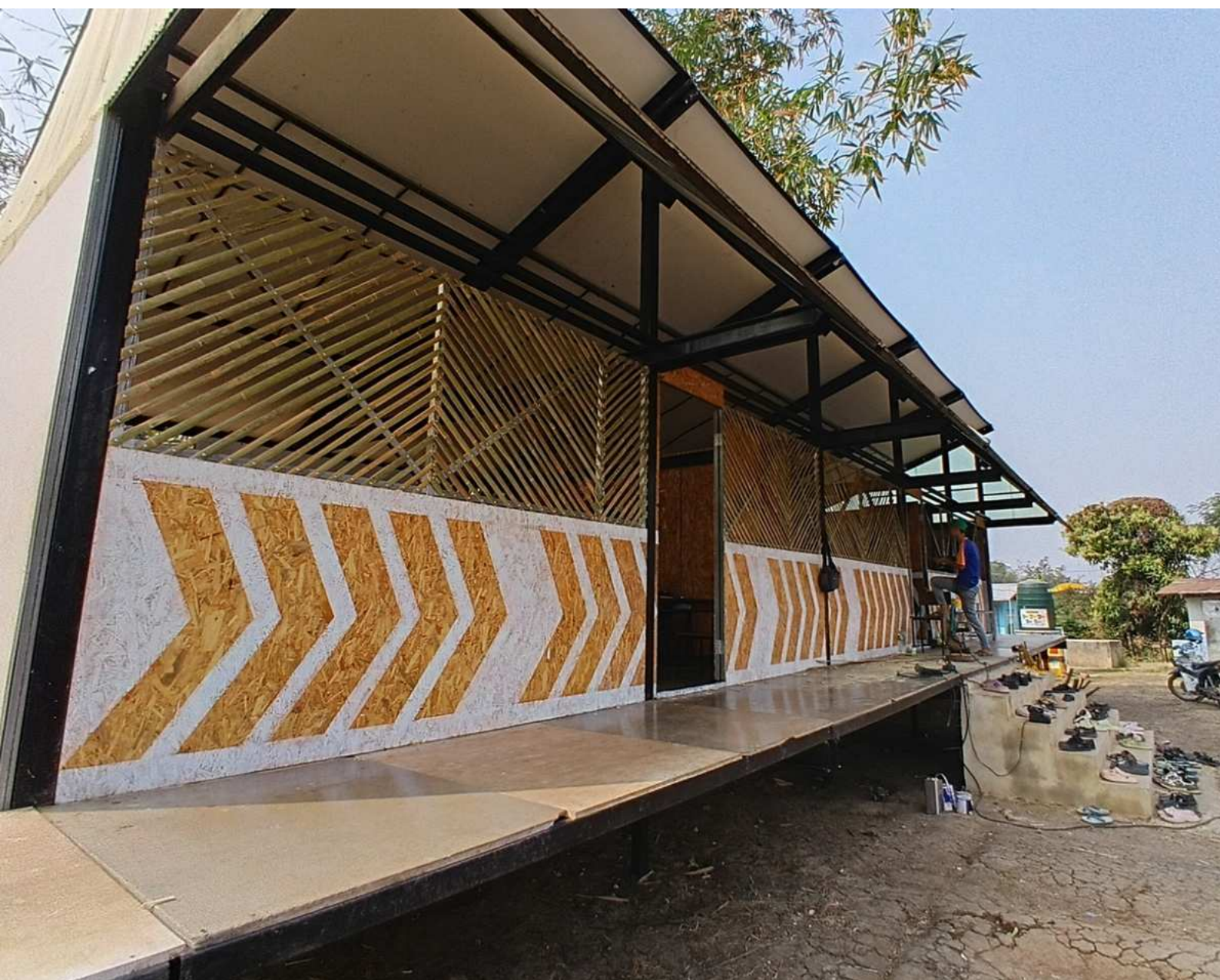
Piccoli lavori di ristrutturazione
