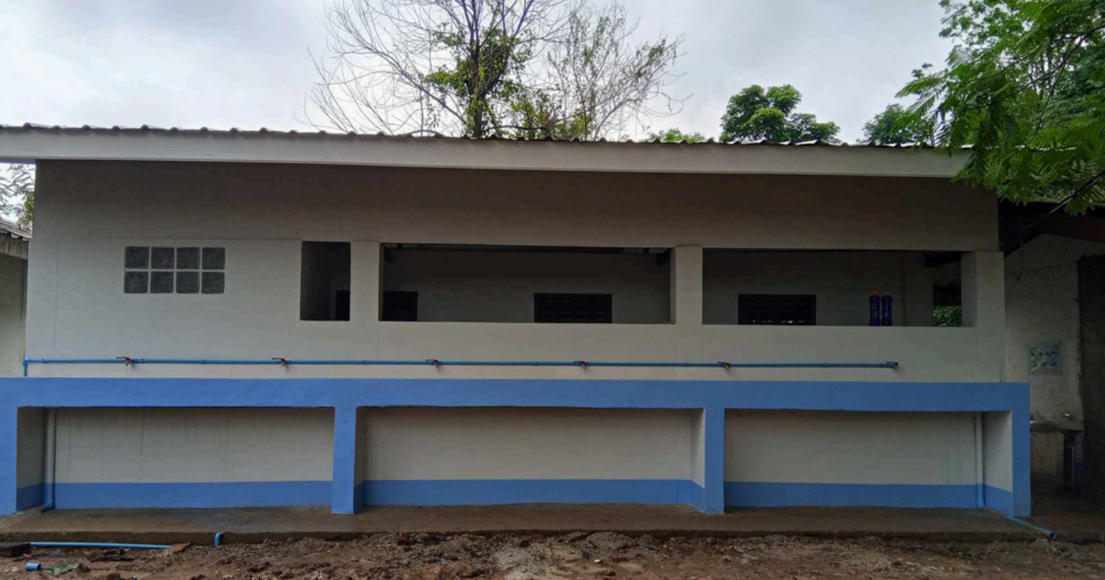
Nuovi impianti sanitari nella scuola
