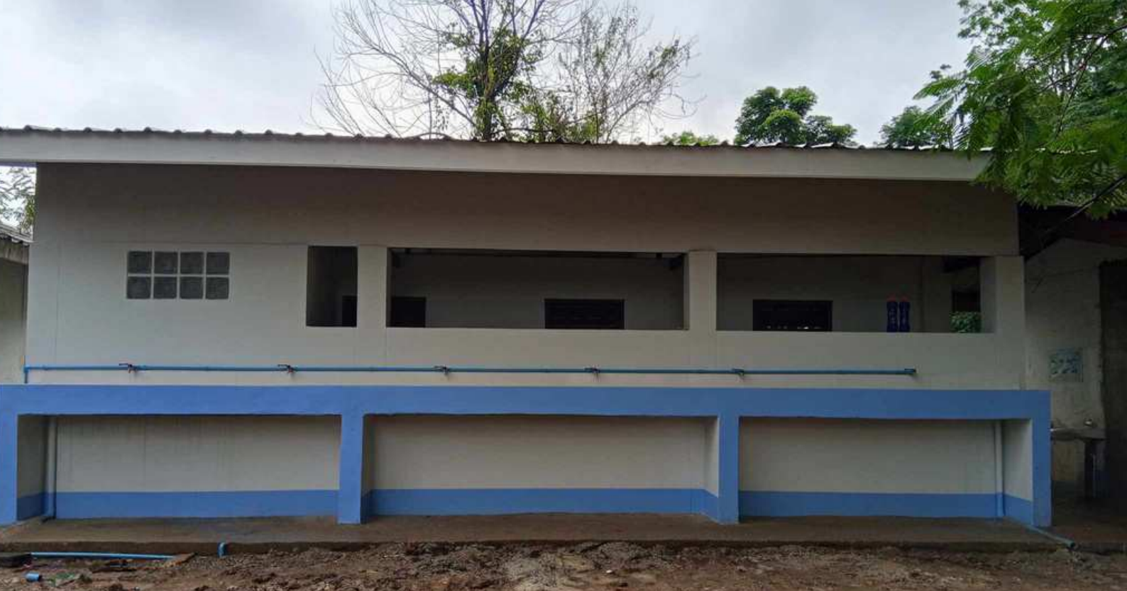
Neue sanitäre Anlagen an der Schule
